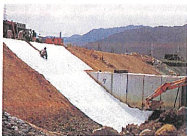
② コンクリートマット敷設
