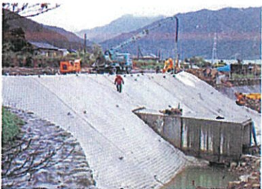
③ コンクリート注入
